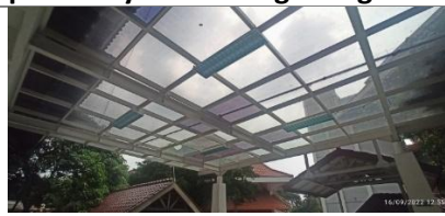
Renovasi atap teras lobi gedung untuk pencahayaan alami
