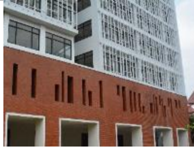
Dinding Terakota untuk mengurangi cuaca panas di dalam gedung Muldis Pertamina
