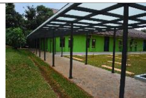
Renovasi atap teras lobi gedung untuk pencahayaan alami
