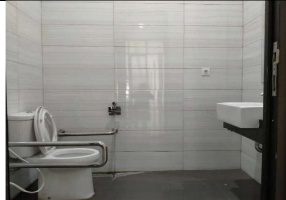
Gambar 9 Fasilitas kamar kecil khusus difabel yang berada di Gedung Riset Multi Disiplin Pertamina
