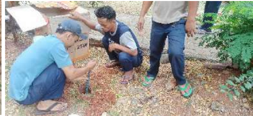
Sumur serapan air hujan baik besar dan kecil terpasang di sekeliling bangunan kampus
