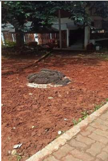
Sumur serapan air hujan baik besar dan kecil terpasang di sekeliling bangunan kampus
