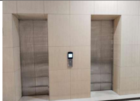
Gambar 6 Lift untuk jalur difabel di Gedung Kuliah
