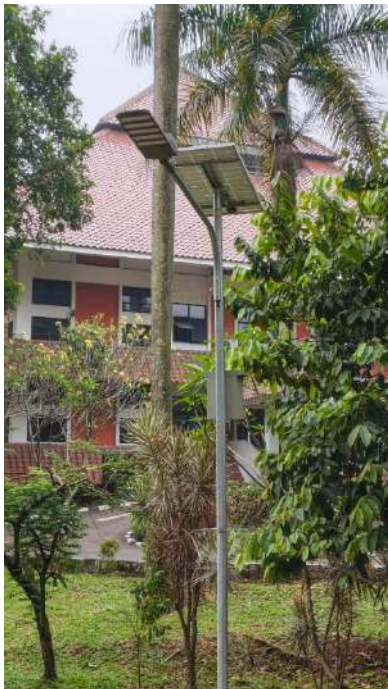
Penggunaan Lampu Penerangan Jalan LED Tenaga Surya
