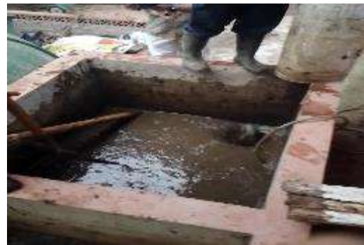
Gambar.8 Setelah bahan limbah diaduk dan tercampur, selanjutnya dimasukkan ke dalam tabung biogester.
