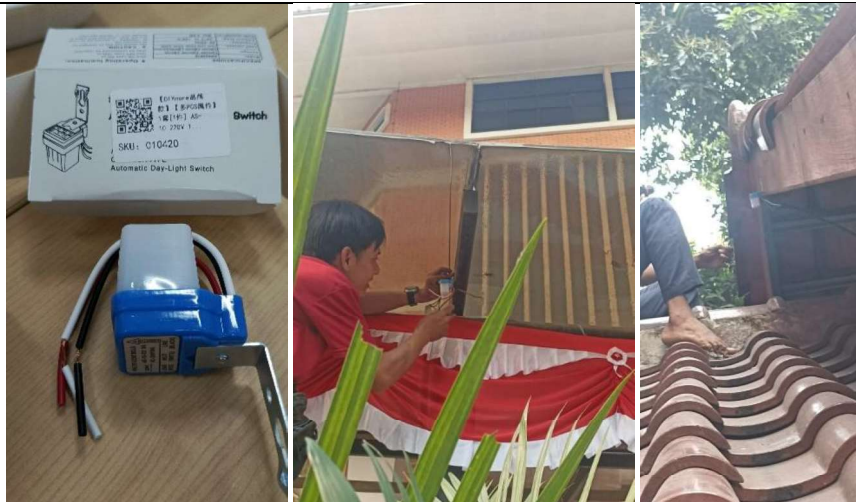
Penggunaan peralatan sensor cahaya untuk menghidupkan lampu di area luar gedung dan selasar. Alat ini digunakan untuk mengatur lampu secara otomatis (menyala jika sudah gelap dan mati jika sudah terang dan dapat diatur dengan penggunaan timer).
