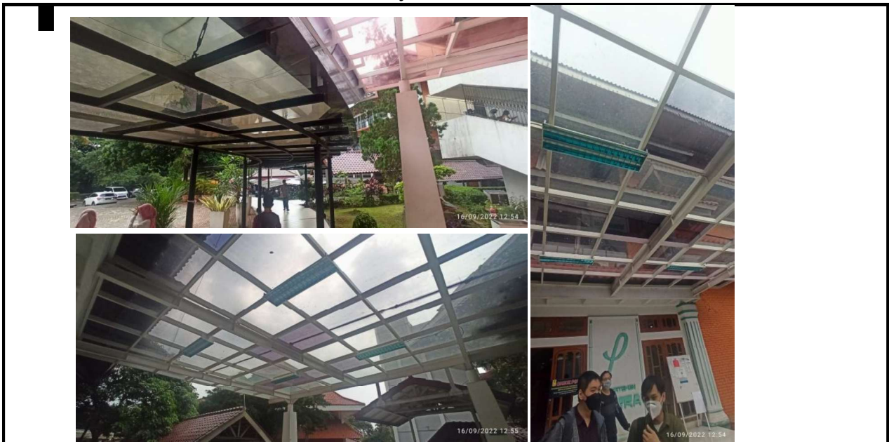
Gambar 9 Renovasi atap teras lobi Gedung Departemen dan selasar Gedung Kuliah untuk pencahayaan alami
