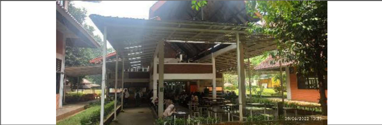
Gambar 4 Ruang terbuka pada Gedung Kantin dan Mushola untuk sirkulasi udara dan pencahayaan alami
